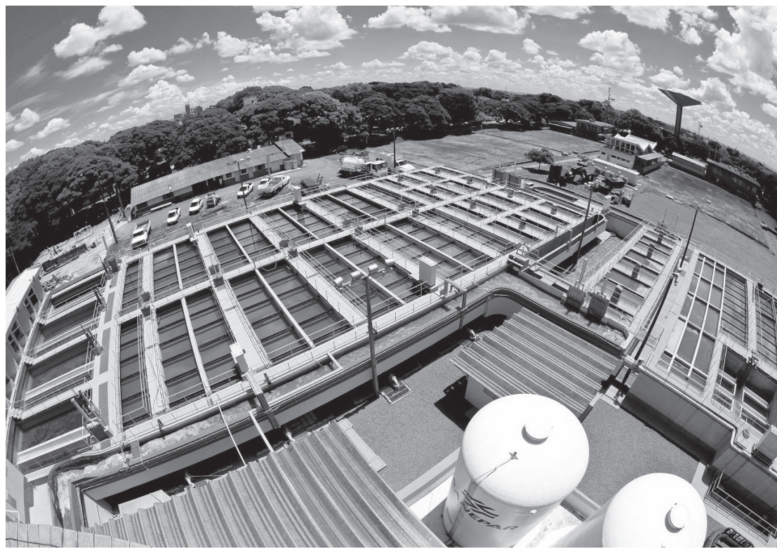
Município declarou que vai assumir os serviços de água e esgoto
